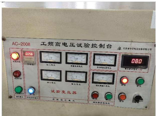
Applied voltage test for SZ-10MVA/35/10KV: H.V.~L.V. & Earth
