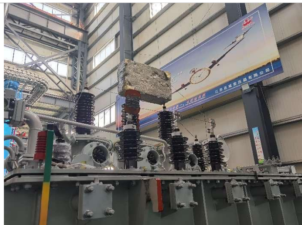
Applied voltage test for SZ-10MVA/35/10KV: L.V.~H.V.& Earth
